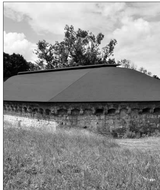
Beluarda - fragment pozostałości dolnego zamku w Rożnowie.
